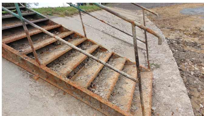
původní schody do nádrže
