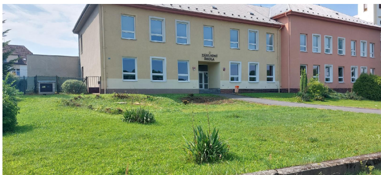
Lokalita plánované kontejnerové přístavby
