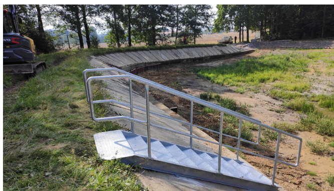
nově vyhotovené schody do nádrže
