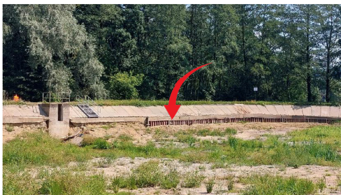
betonáž hráze vodní nádrže
